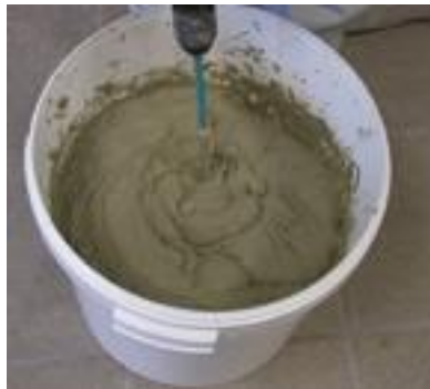
El mortero se mezcla con un agitador. Comp. A + B poner en un cubo de 30 l y mezclar bien durante 2 min- listo.
