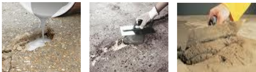
La consistencia del líquido o la consistencia con un mortero es ajustable individualmente
